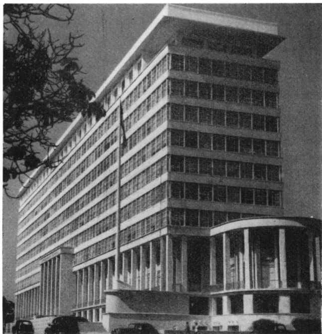
Il Bâtiment Fédéral, sede del Governo Federale del Mali
